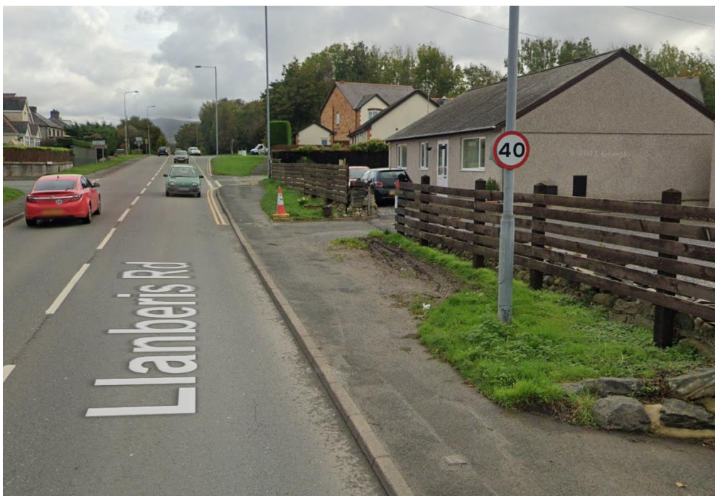
Lluniau o Google Street view Mis Hydref 2021
